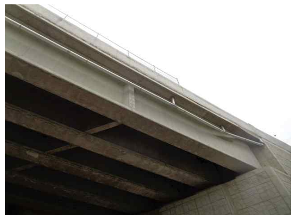
배수관 상태 양호-문산방향
