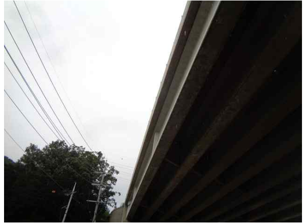
바닥판 하면 상태양호-서울방향
