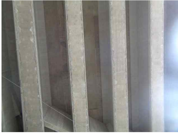
바닥판 하면 상태양호-서울방향
