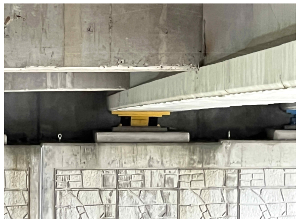
교량받침 A1-SH4 상태양호-서울방향
