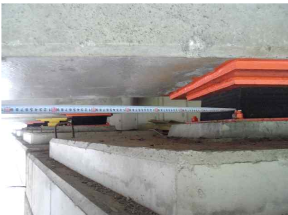
받침장치 연단거리 측정
