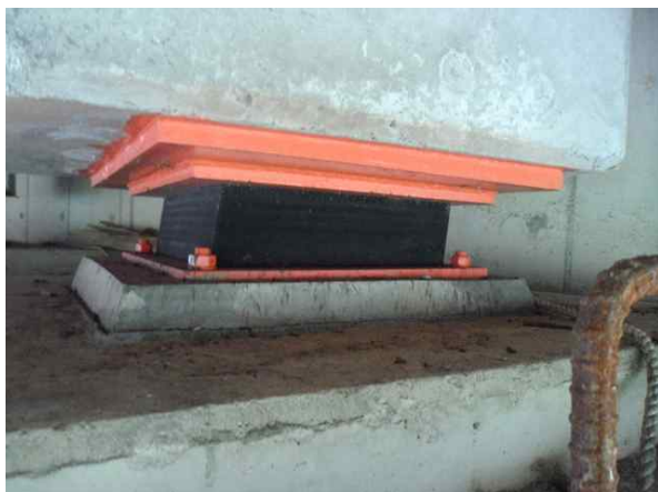
교량받침 A2-SH5 상태양호-서울방향
