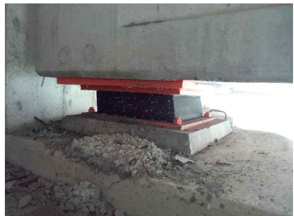
교량받침 A2-SH2 상태양호-문산방향
